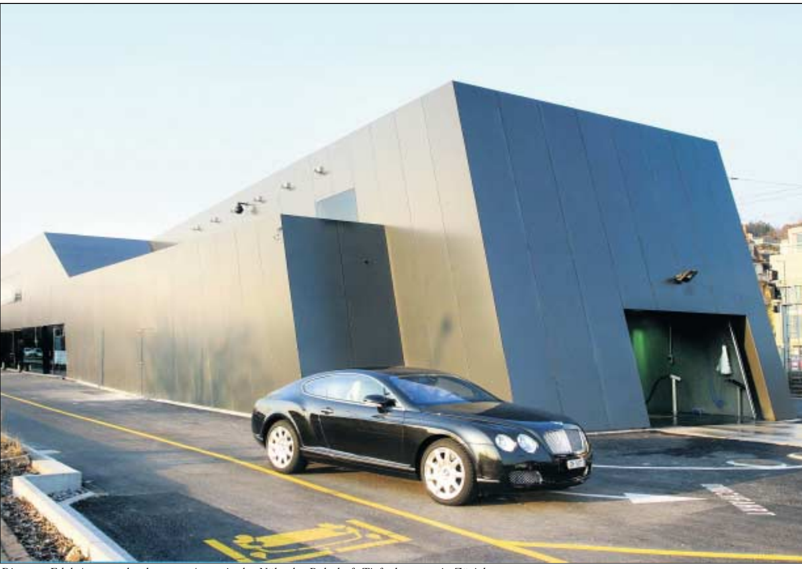
Die neue Edel-Autowaschanlage von Autop in der Nähe des Bahnhofs Tiefenbrunnen in Zürich.
